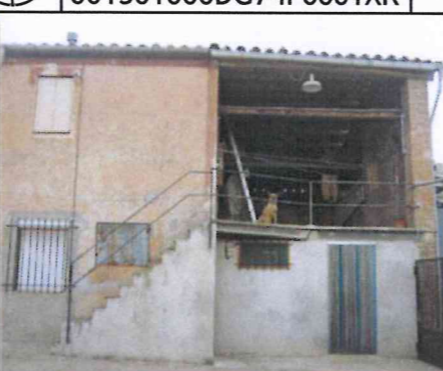
Façana est: ampliació
