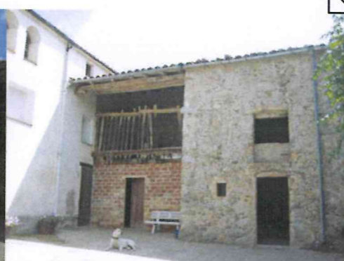
Façana sud (pallissa)
